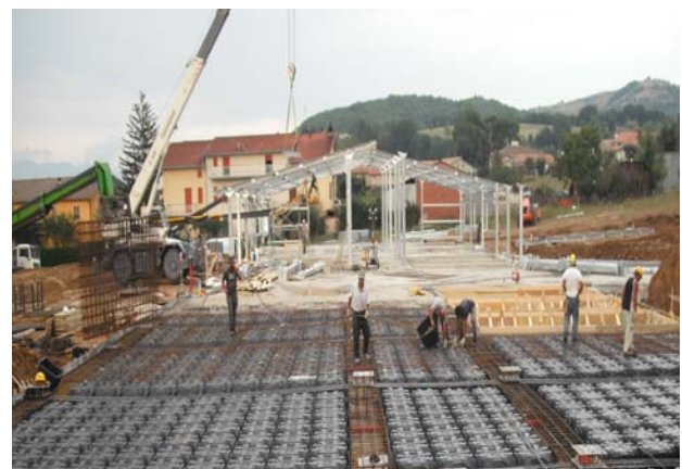
Posa completa della fondazione con Modulo
