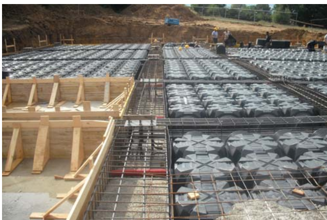
Dettaglio sistema Modulo e chiusura perimetrale
