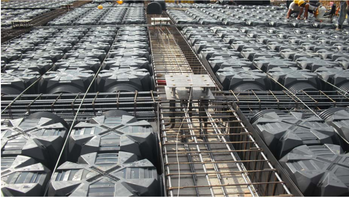
Dettaglio nodo trave di fondazione – colonna acciaio
